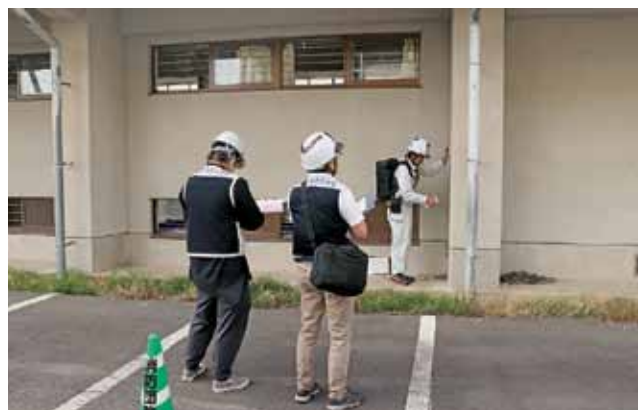
柱の傾斜測定
