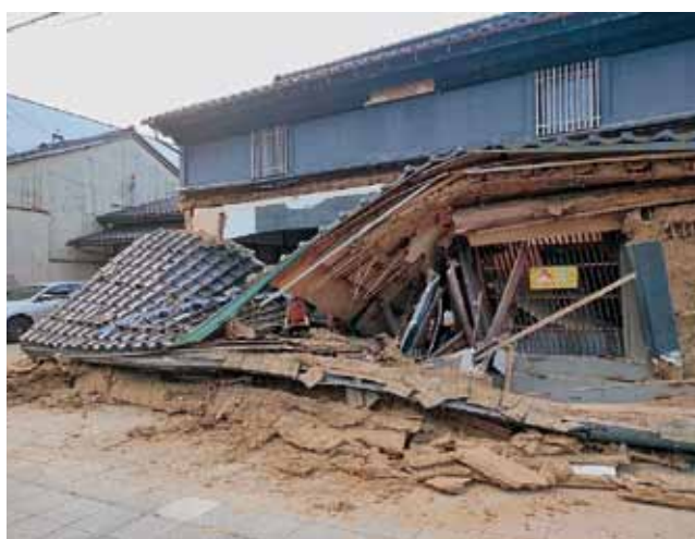
解体前の写真
