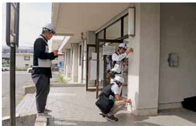
柱の傾斜測定
