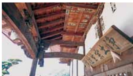
本堂向拝見上げ
