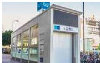
防水シャッター
