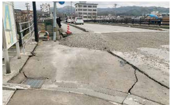
周辺道路の沈下により、橋との段差が発生。碎石で仮補修し通行が可能になっていました。
