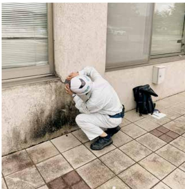
外壁のクラックゲージによる計測
