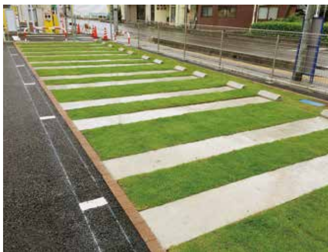
駐車場緑化施工例
