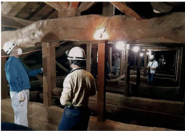
小屋裏調査風景
