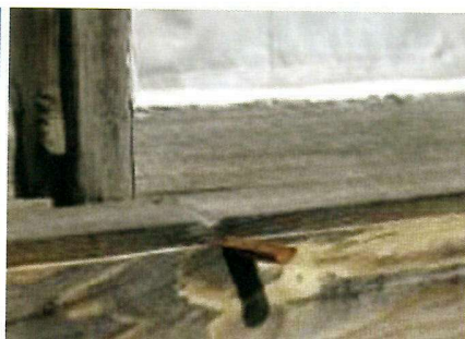
外壁 窓枠水落とし (シュメール)
