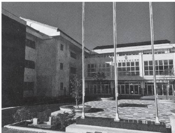
〔I 小学校竣工写真〕
